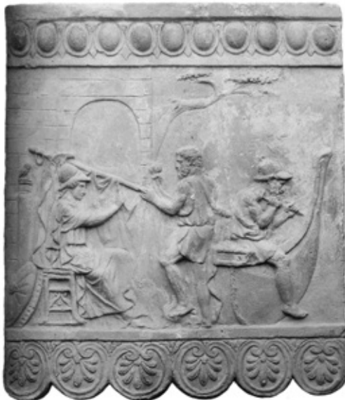
Construcción del “Argos”. El panel de terracota romano recrea el momento en que se está construyendo el navío. El armado del mismo se llevó a cabo en Pagaso.
